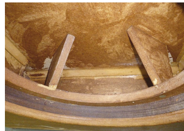
Внутри — планки в местах стыка панелей и раскосы для жёсткости
